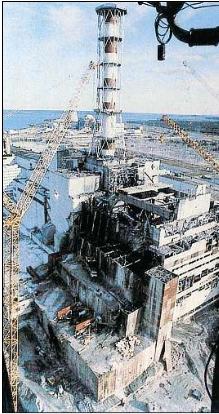
La centrale de Tchernobyl après la double explosion qui l'a secouée. Un sarcophage de béton sera coulé à la hâte pour emprisonner les débris radioactifs, mais les conséquences de la catastrophe seront telles qu'il est aujourd'hui encore difficile de les appréhender.
